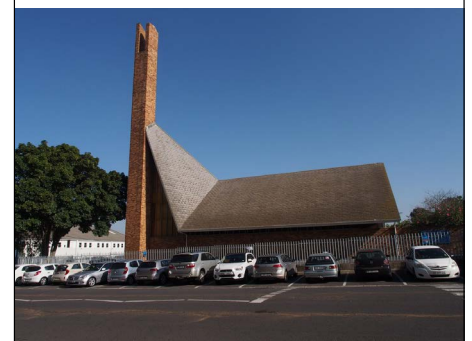
11. BELLVILLE GEREFORMEERDE CHURCH
